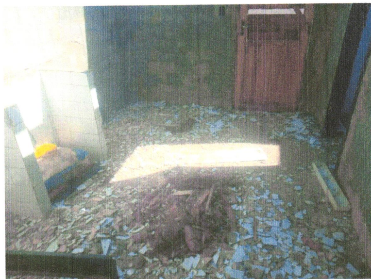
FOTO 04 - Demolição de revestimento cerâmico ou azulejo
