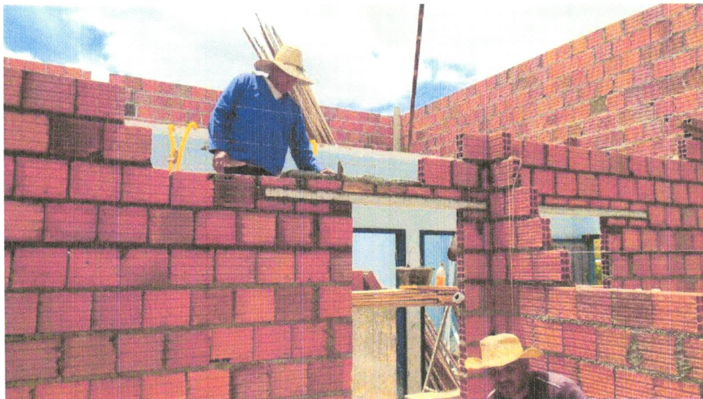
FOTO 09 – VERGA PRÉ-MOLDADA PARA JANELAS COM ATÉ 1,5 DE VÃO. AF_03/2016
