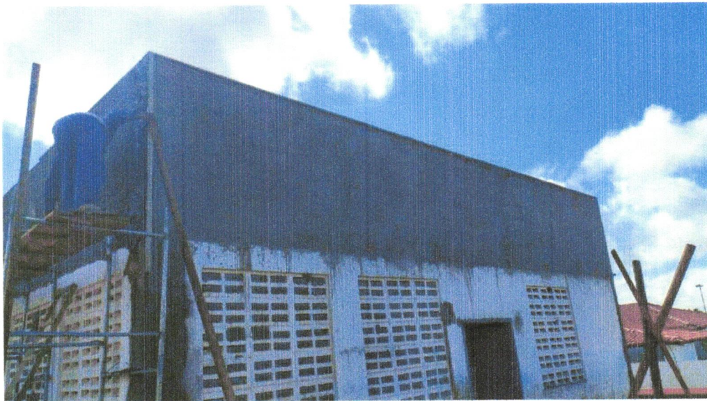
Foto 16 - MASSA ÚNICA, PARA RECEBIMENTO DE PINTURA OU CERÂMICA, ARGAMASSA INDUSTRIALIZADA, PREPARO MECÂNICO, APLICADO COM EQUIPAMENTO DE MISTURA E PROJEÇÃO DE 1,5 M 3 /H EM FACES INTERNAS DE PAREDES, ESPESSURA DE 5MM, SEM EXECUÇÃO DE TALISCAS. AF_06/2014
