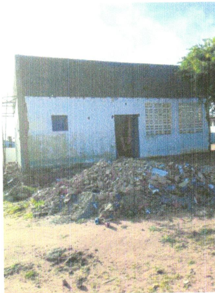
FOTO 01 – CHAPISCO APLICADO EM ALVENARIA (COM PRESENÇA DE VÃOS) E ESTRUTURAS DE CONCRETO DE FACHADA, COM EQUIPAMENTO DE PROJEÇÃO. ARGAMASSA TRAÇO 1:3 COM PREPARO EM BETONEIRA 400 L. AF_06/2014
