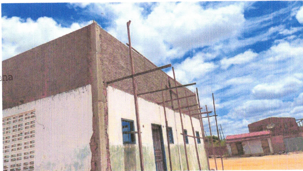
FOTO 06 – CHAPISCO APLICADO EM ALVENARIA (COM PRESENÇA DE VÃOS) E ESTRUTURAS DE CONCRETO DE FACHADA, COM EQUIPAMENTO DE PROJEÇÃO. ARGAMASSA TRAÇO 1:3 COM PREPARO EM BETONEIRA 400 L. AF_06/2014
