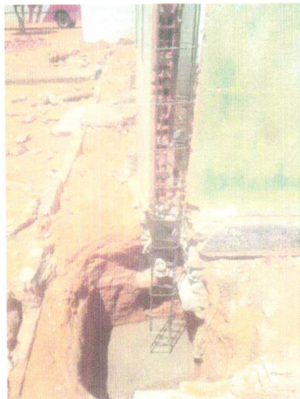
Foto 14- LASTRO DE CONCRETO MAGRO, APLICADO EM BLOCOS DE COROAMENTO OU SAPATAS, ESPESSURA DE 3 CM. AF_08/2017
